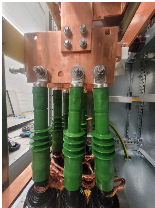
samoróbka instalatora z szyną
