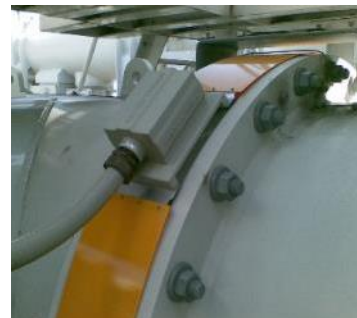
Zdjęcia typowych sond UHF stosowanych w GIS
