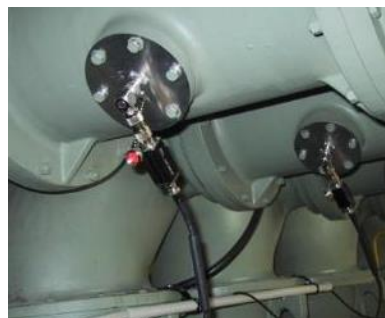
Zdjęcia typowych sond UHF stosowanych w GIS
