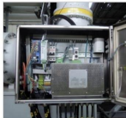
Przykład jednostki rejestracji danych usytuowanej w pobliżu sondy UHF
