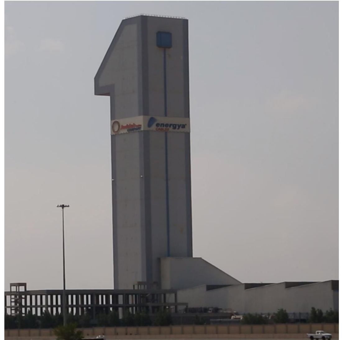
Arabia Saudyjska - od 1989 roku, VCV line 125m - Pierwsza w Arabii Saudyjskiej do 500kV
