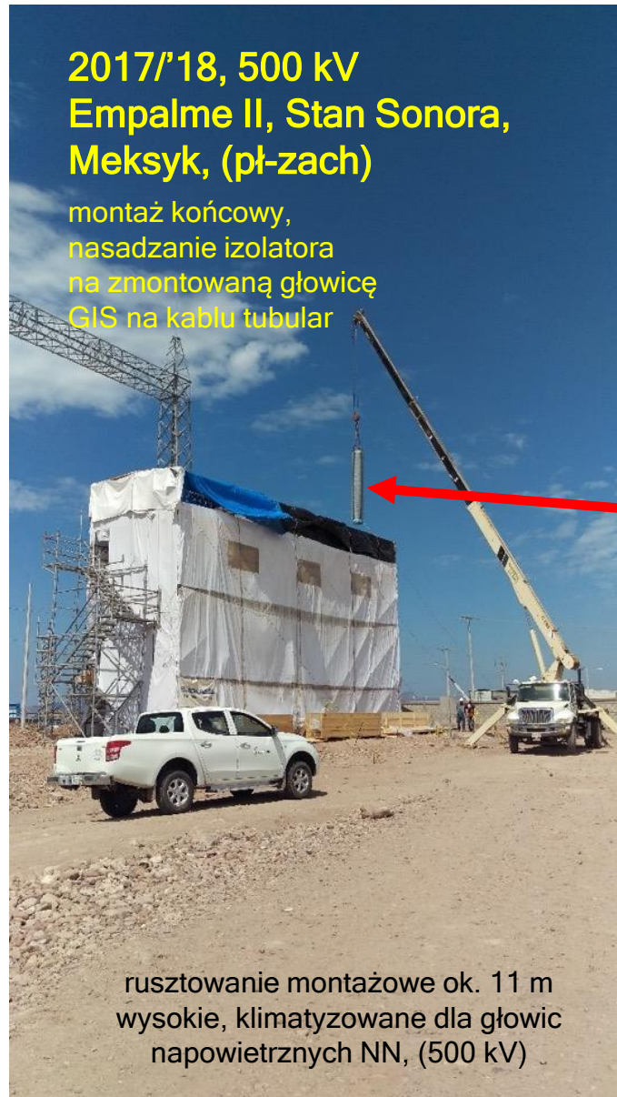
tymczasowe zamocowanie kabla po ułożeniu i przed postawieniem rusztowania montażowego
